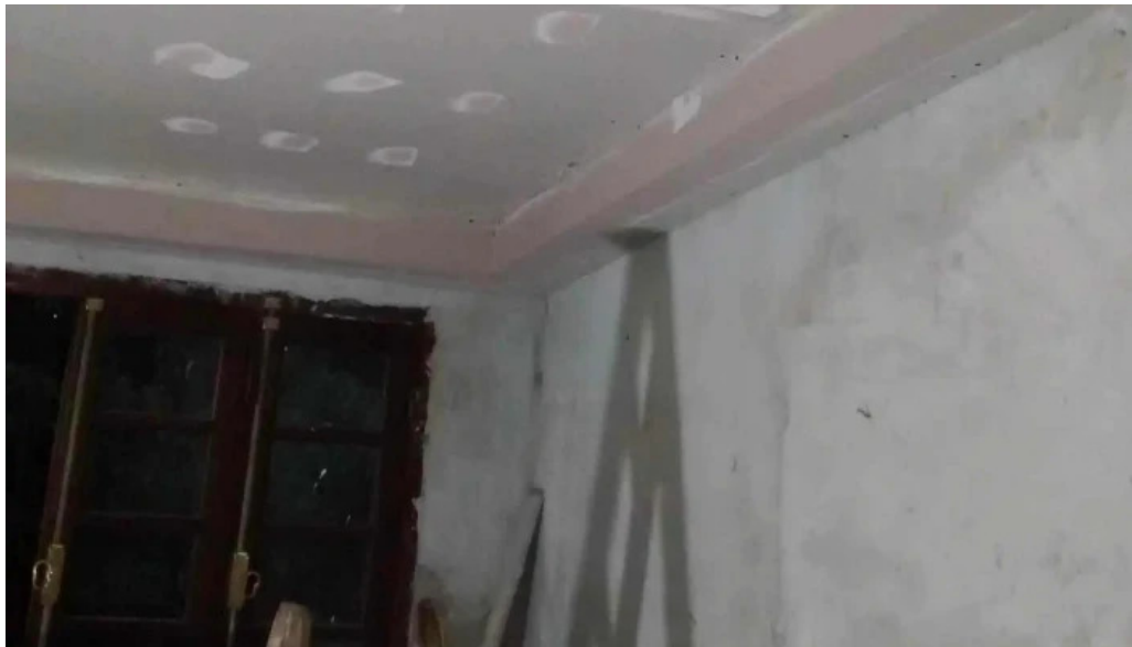
El galpon maderas distribuidor knauf steel frame instagram
