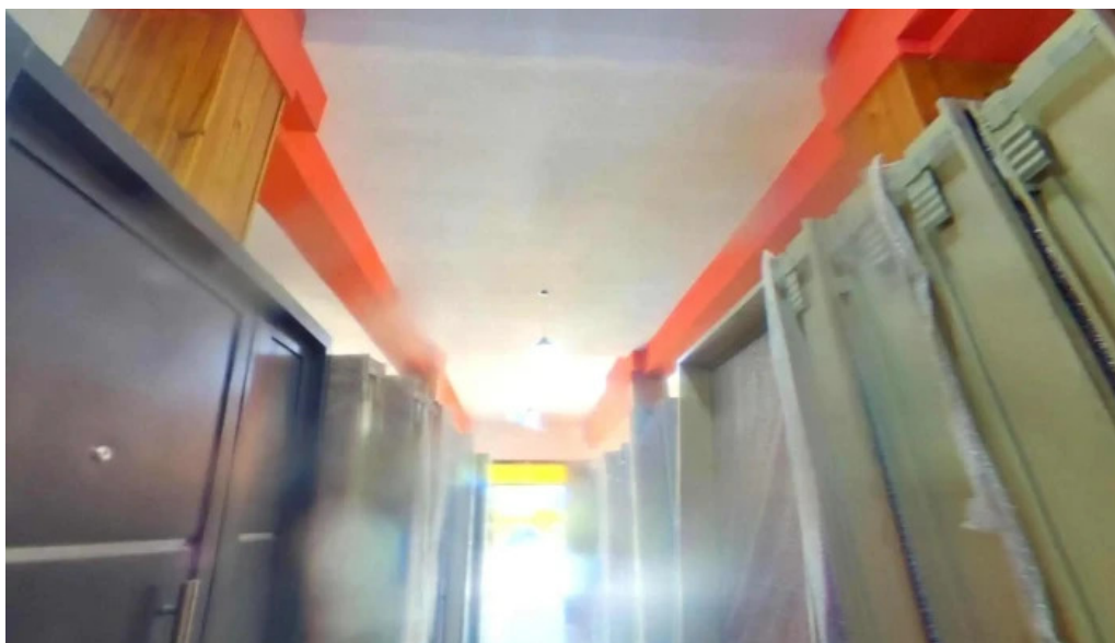
Progreso aberturas edificio
