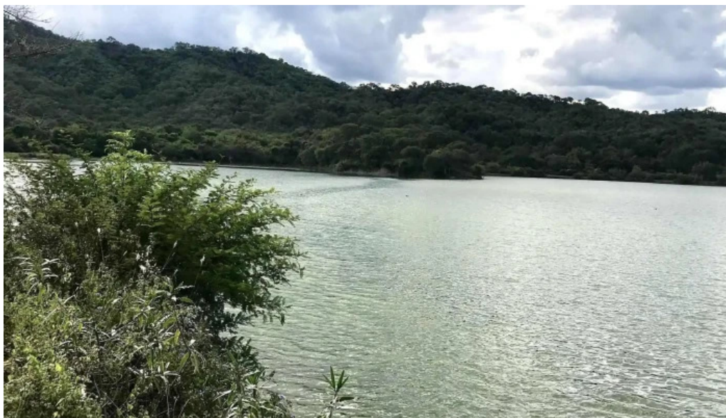
Dique puerta de diaz ubicacion
