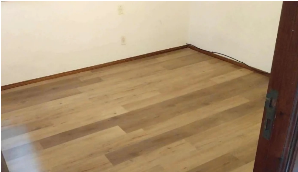
Colocacion pisos de madera en santa fe mg restauracion catalogo
