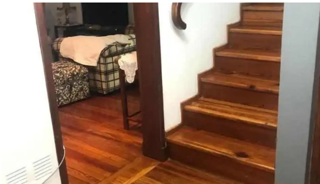
Colocacion pisos de madera en santa fe mg restauracion interior
