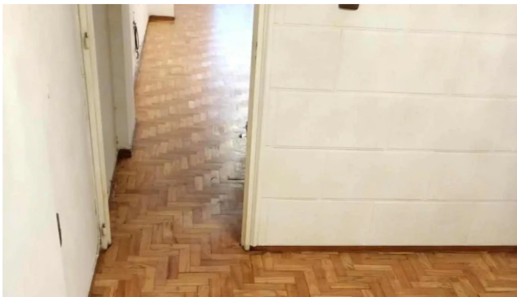
Colocacion pisos de madera en santa fe mg restauracion horario
