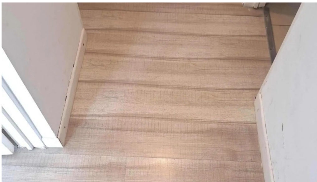
Colocacion pisos de madera en santa fe mg restauracion instagram
