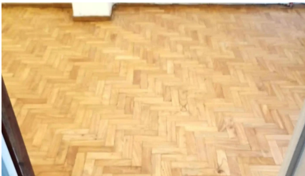
Colocacion pisos de madera en santa fe mg restauracion precios
