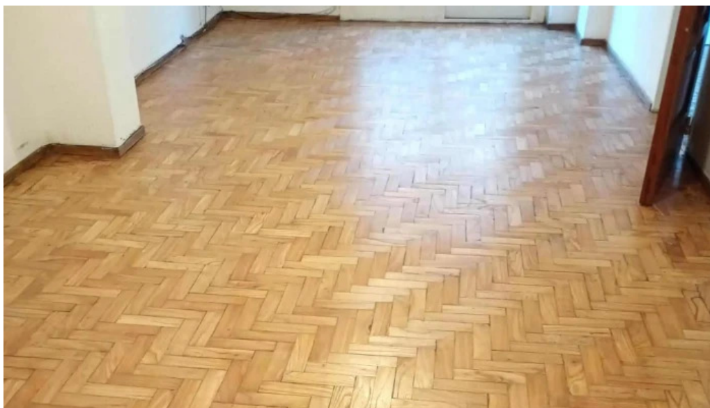
Colocacion pisos de madera en santa fe mg restauracion zona
