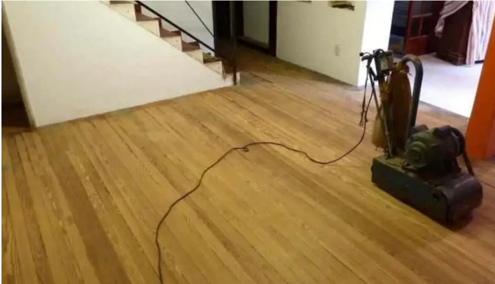
Colocacion pisos de madera en santa fe mg restauracion del propietario
